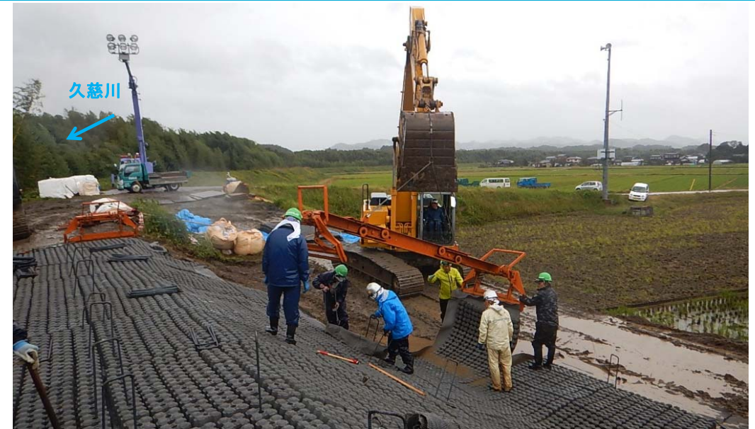
2019.10.25 15時00分頃 ブロックマット設置 施工中
