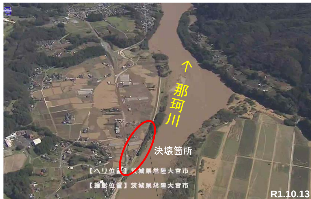
那珂川水系 那珂川左岸40.0k付近
