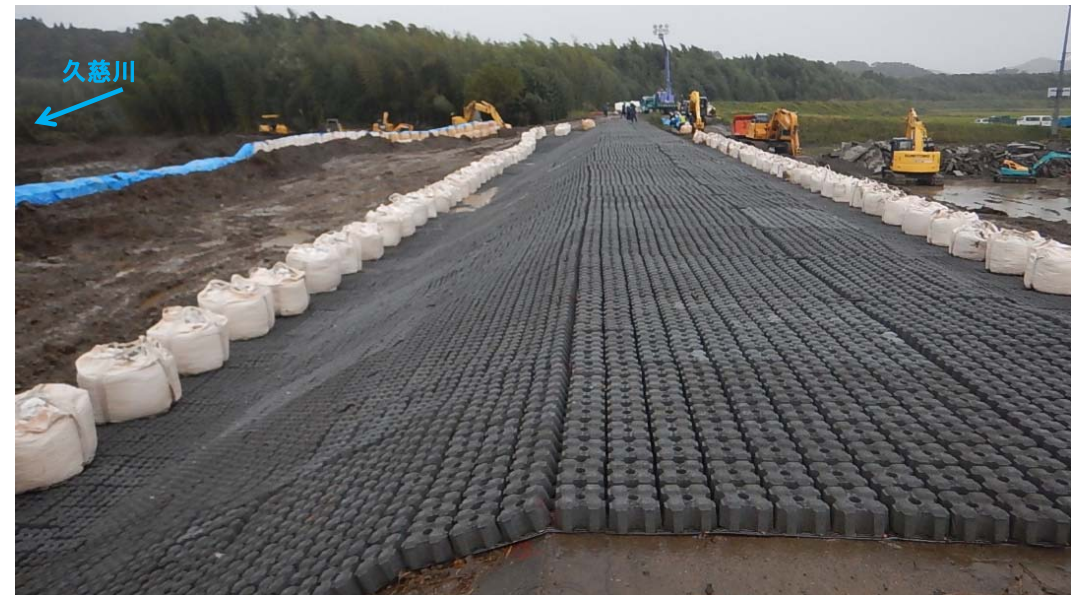
完成状況写真 2019.10.25 19時00分頃
