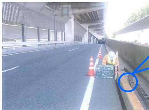
堆積率50%以上でパトロール車通過時にセンサーが反応し、点灯。
