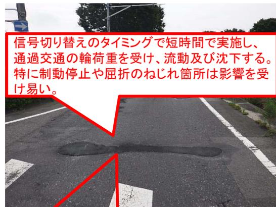
信号切り替えのタイミングで短時間で実施し、通過交通の輪荷重を受け、流動及び沈下する。特に制動停止や屈折のねじれ箇所は影響を受け易い。
