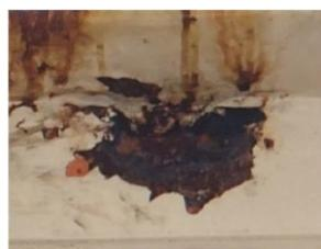
橋面から腐食が進展するため桁下面からは残存板厚の予測が困難 (局所腐食部B部橋面側)
