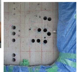
(鉄筋挿入にあたり、奥の鉄筋に干渉するため、多くの削孔をしている状況)
