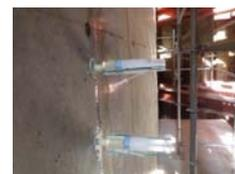
低圧低速注入工法による補修
