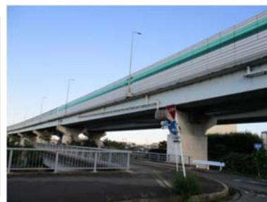
暫定的に低く設置してある遮音壁も沿道開発で嵩上げされると同様の形状に至る
