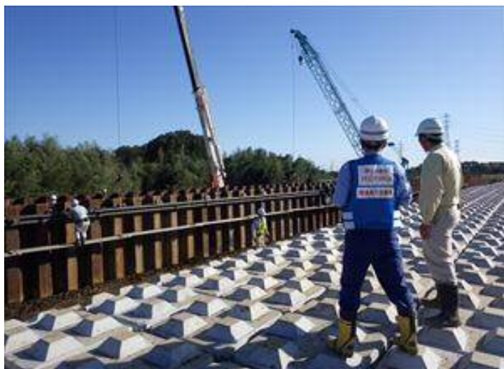
都幾川の復旧作業状況(埼玉県東松山市)
