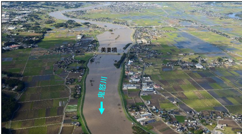
茨城県常総市大輪町・中妻町地先 (鬼怒川16.00km付近)
