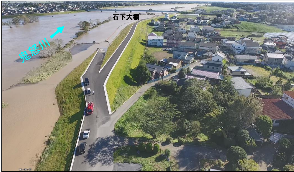
茨城県常総市向石下地先 (鬼怒川右岸23.00km付近)
