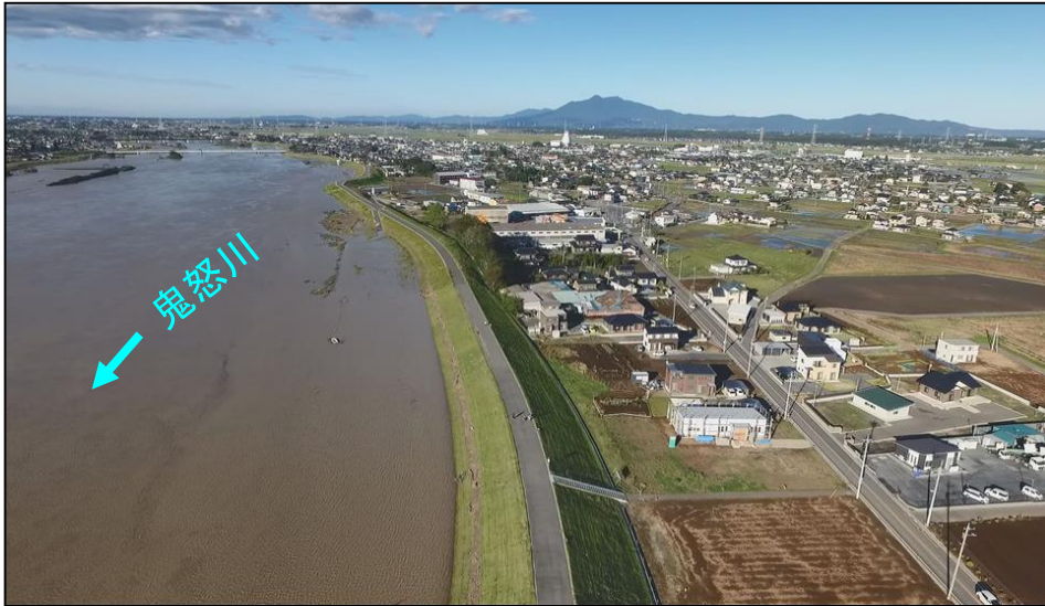
茨城県常総市上三坂地先 (鬼怒川左岸20.75km付近)
