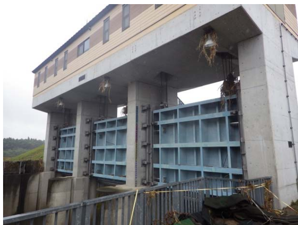
扉体シーブ部浮遊物堆積 (烏山江川樋門)
