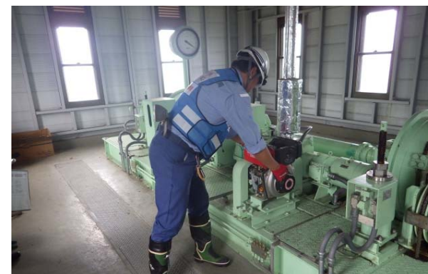
電動操作不能箇所 予備動力稼働確認 (烏山江川樋門)
