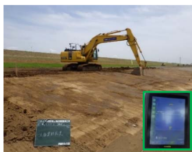
法面整形状況
