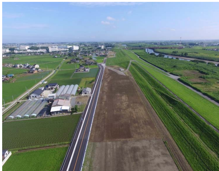
盛土完了全景
