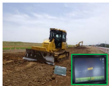
法面整形状況
