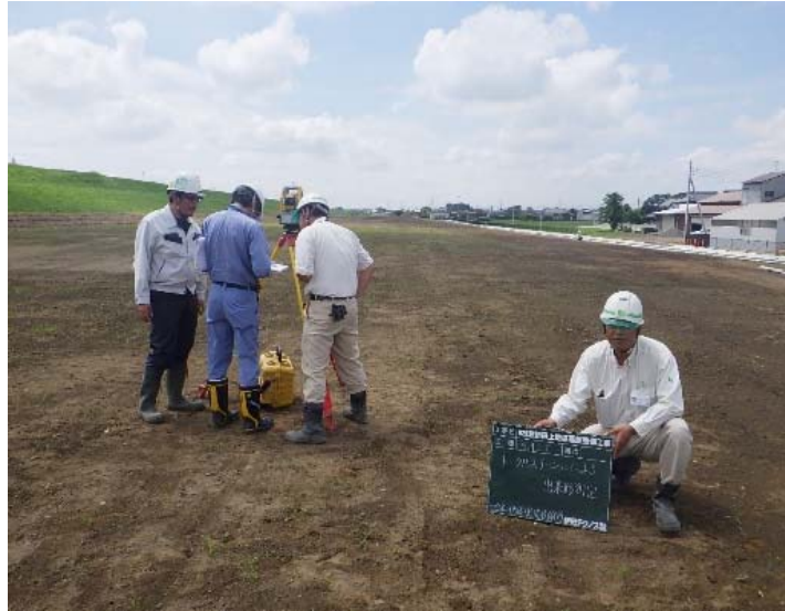
TSによる出来形測定
