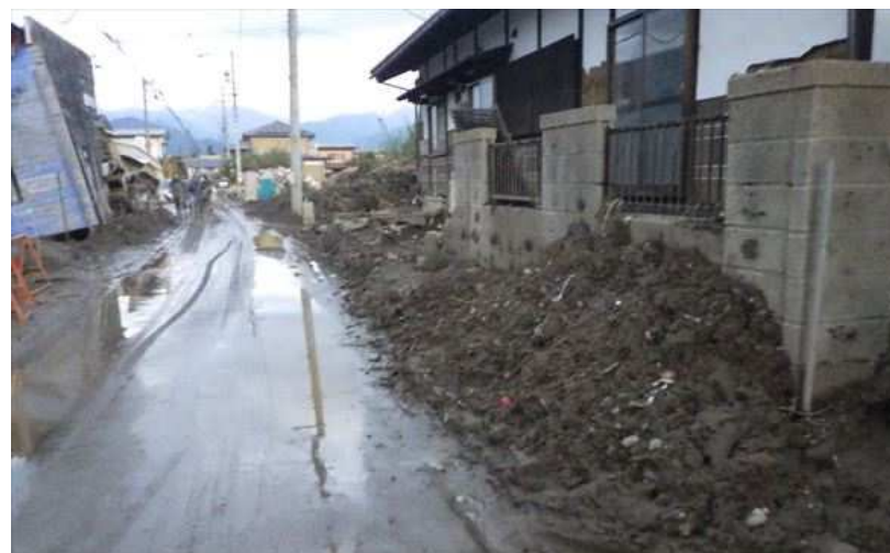
道路の路面被災状況(長野県長野市)
