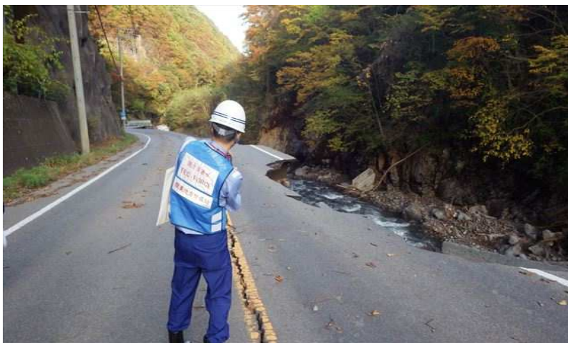
被災状況調査(群馬県吾妻郡嬬恋村)
