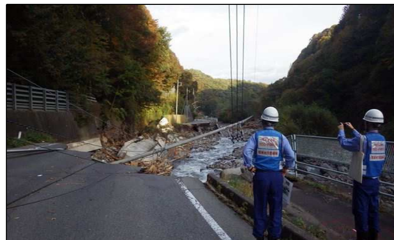
被災状況調査(群馬県吾妻郡嬬恋村)
