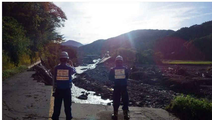
被災状況調査(群馬県吾妻郡嬬恋村)
