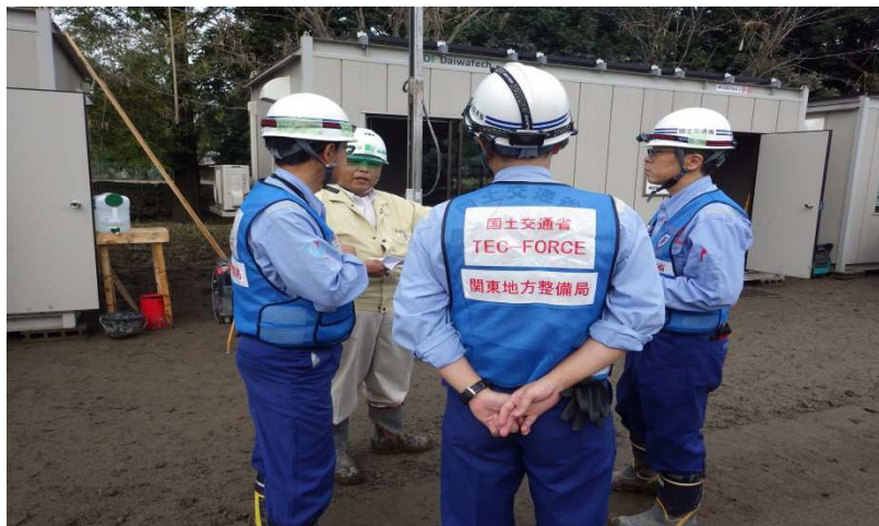
河川の復旧作業状況打合せ(埼玉県東松山市)
