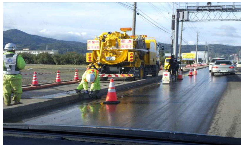
道路の路面清掃状況(長野県長野市)
