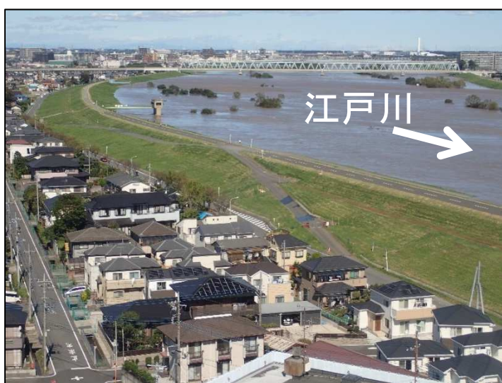
江戸川出水状況(埼玉県三郷市付近)
