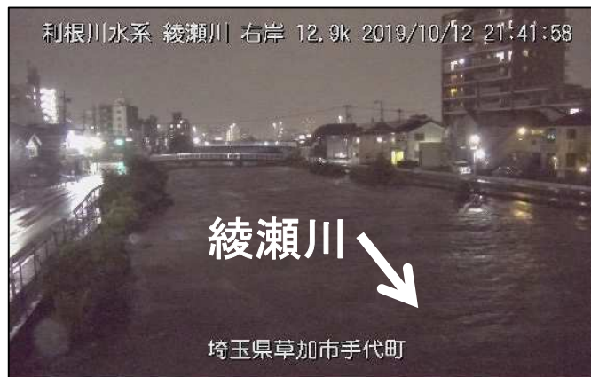
綾瀬川出水状況(埼玉県草加市付近)
