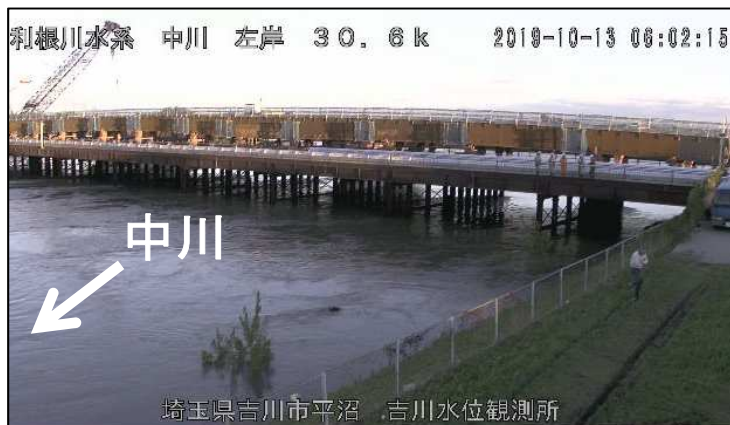
中川出水状況(埼玉県吉川市付近)
