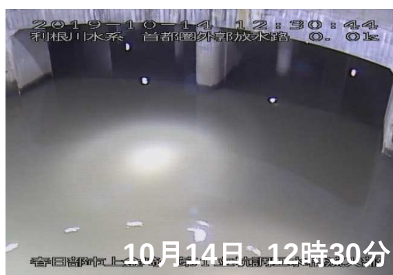
第1立坑から調圧水槽への流入状況
