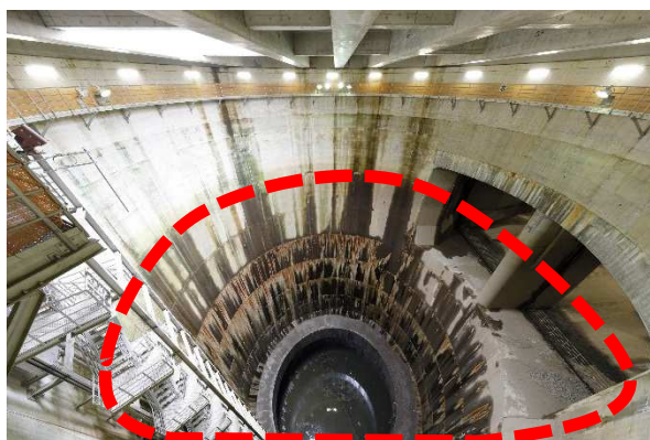
第1立坑から調圧水槽への流入状況
