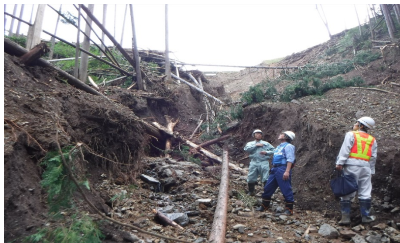
市道の被災状況調査(栃木県栃木市)
