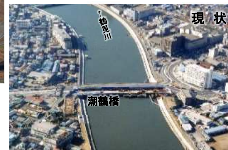
河道改修により、河道能力が大幅にアップ
