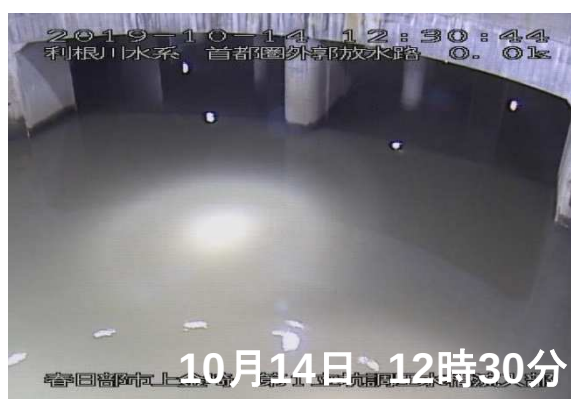
第1立坑から調圧水槽への流入状況
