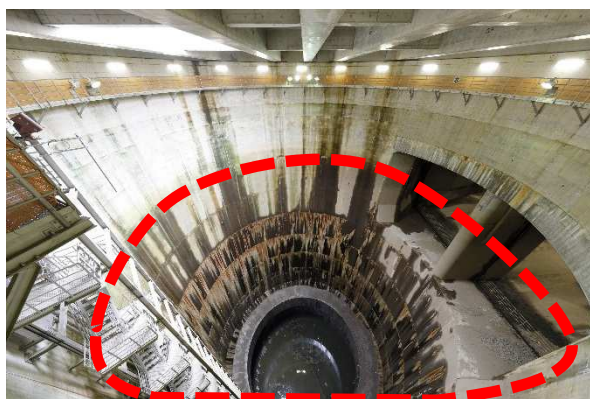
第1立坑から調圧水槽への流入状況
