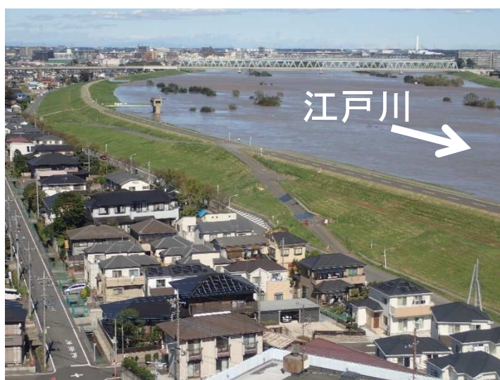
江戸川出水状況(埼玉県三郷市付近)
