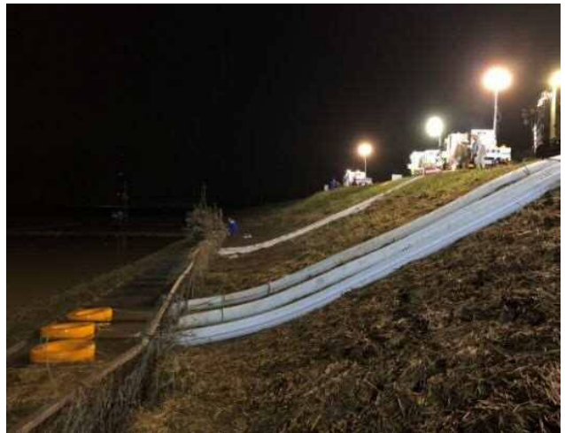
10月14日 設置状況（川裏）
