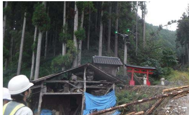
ドローンによる被災状況調査(栃木県鹿沼市)
