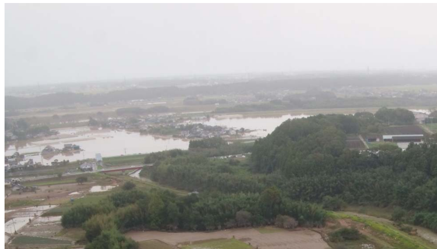
藤井川破堤箇所のドローン調査
