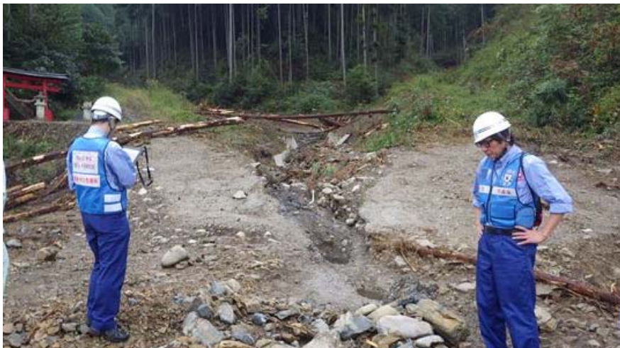
砂防の被災状況調査(栃木県鹿沼市)
