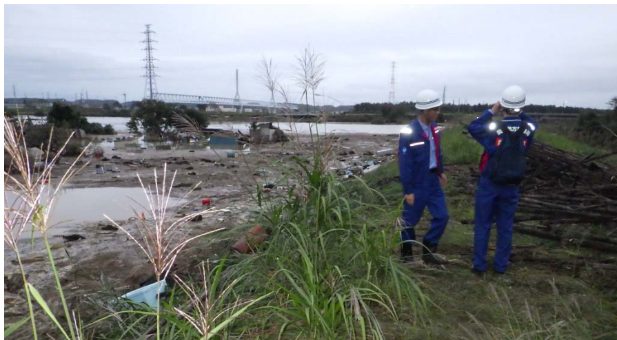
水戸北スマートIC周辺の被災状況調査
