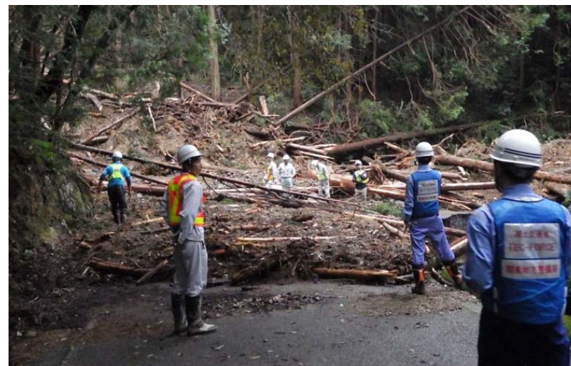
市道の被災状況調査(栃木県栃木市)
