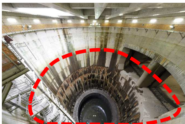
第1立坑から調圧水槽への流入状況
