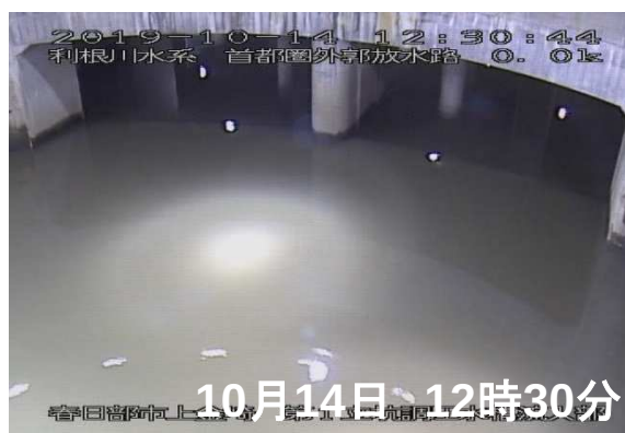
第1立坑から調圧水槽への流入状況
