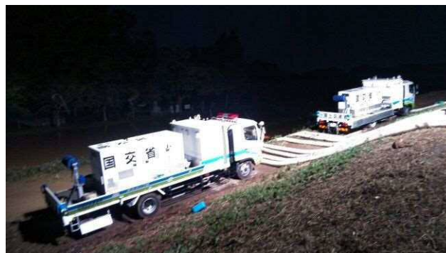
ポンプ車展開状況
