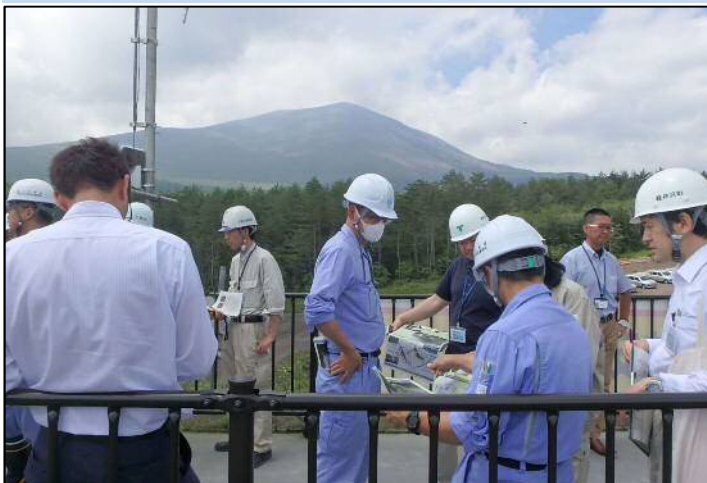
片蓋川第二砂防堰堤工事 進捗状況の説明状況
