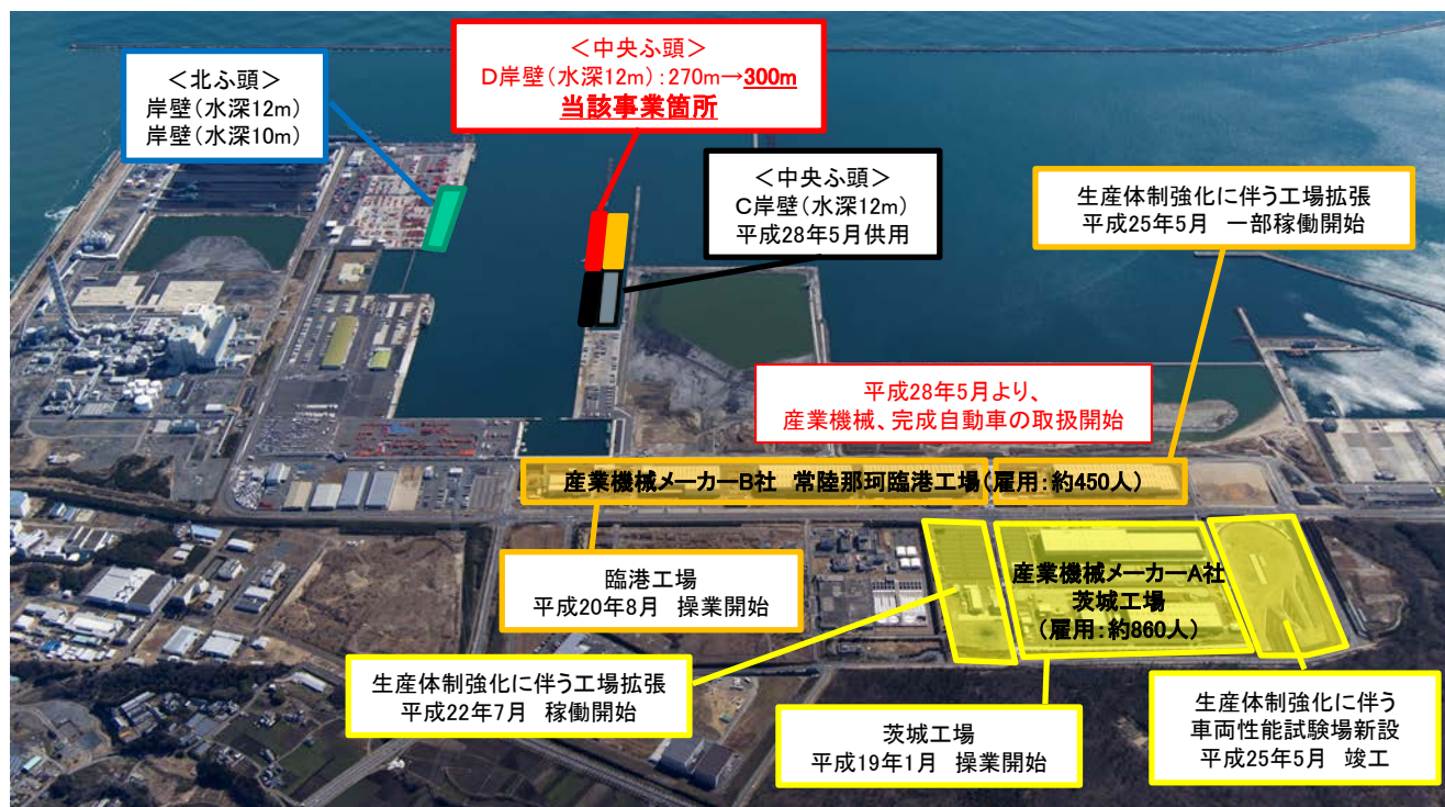
常陸那珂港区の施設状況
