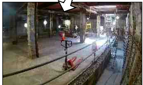
① 藤沢回転立坑施工状況(R1.6時点)
