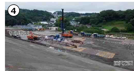
④-1 横浜坑口施工状況(R1.6時点)
