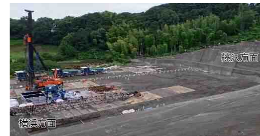
④-2 横浜坑口施工状況(R1.6時点)
