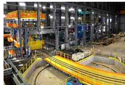
③-2 発進立坑地上設備内部(R1.6時点)
