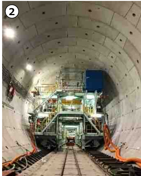
② シールド坑内施工状況(R1.6時点)
