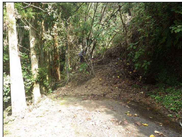
市道を塞ぐ土砂崩れの状況(富津市)
