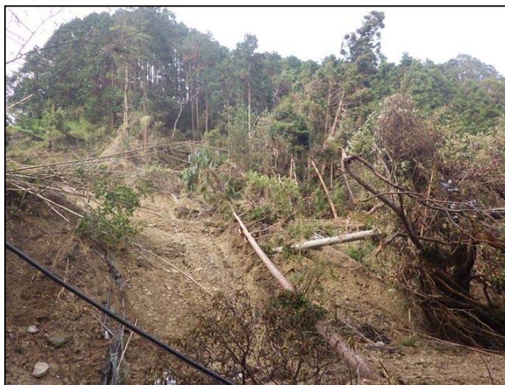
電柱や法面が崩れている状況(富津市)
