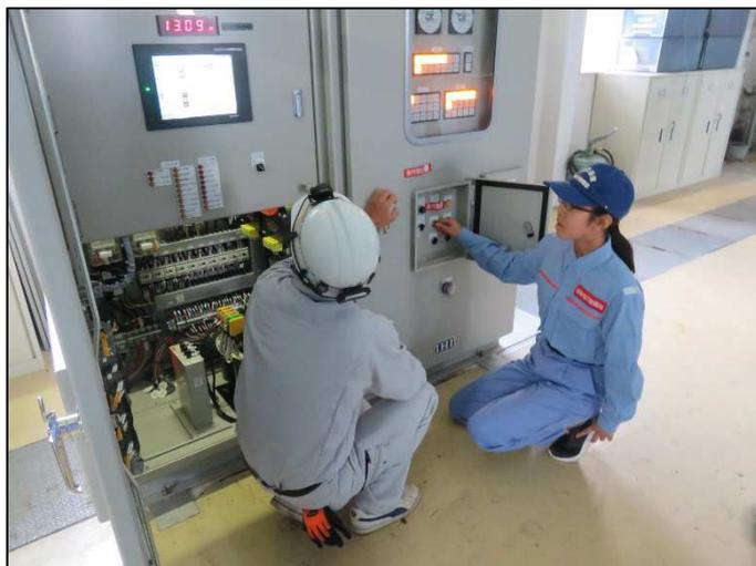
選択取水設備試験操作
