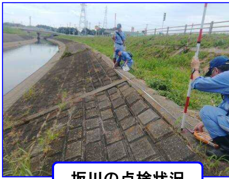
坂川の点検状況
