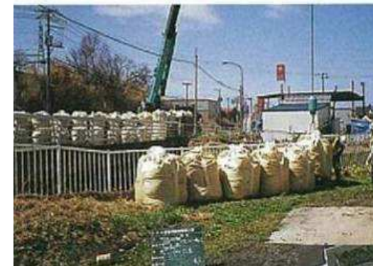
図. 大型土のうによる導流工の施工事例 (国土交通省 北海道開発局)
