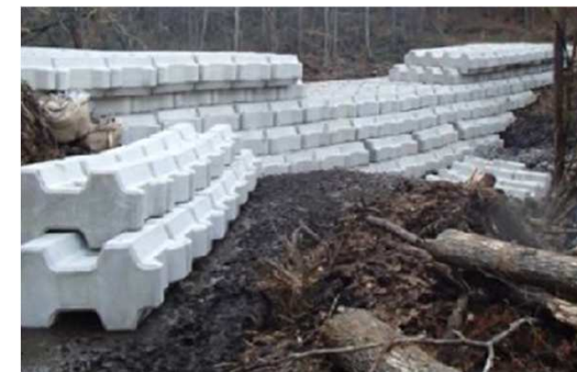
図. コンクリートブロックによる不透過型砂防堰堤の施工事例 (国土交通省 中部地方整備局 多治見砂防国道事務所管内 鹿ノ瀬川)
