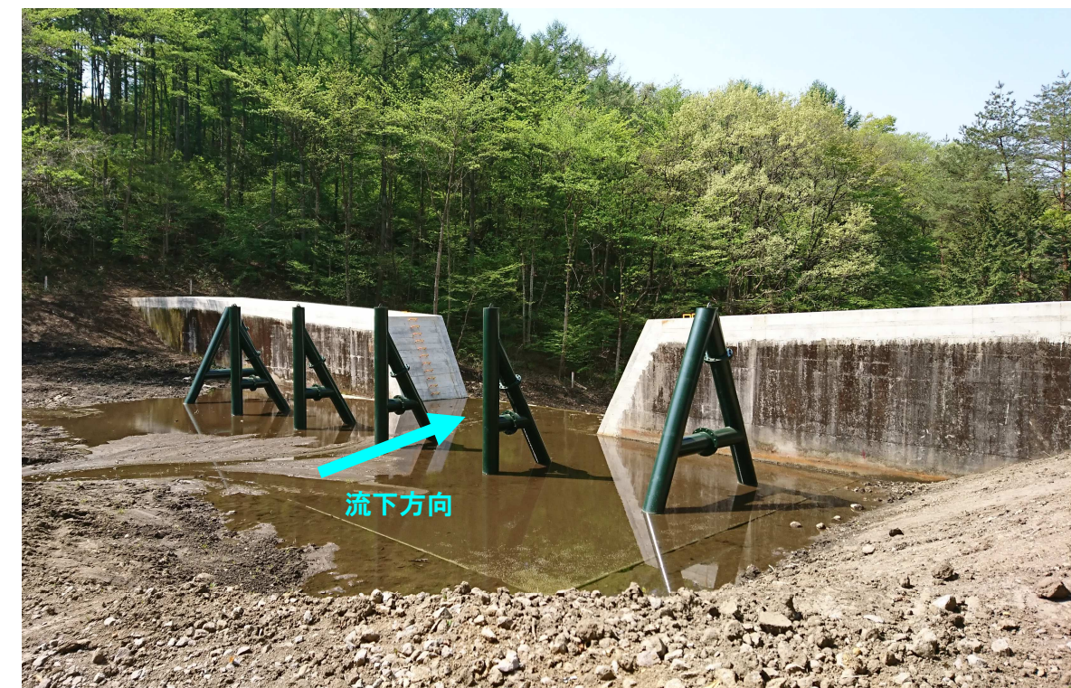
図. 砂防施設堆砂域内の張り出し工施工事例 (長井川砂防堰堤(利根川水系砂防堰堤))
