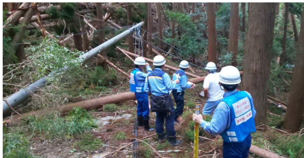
現地調査状況
