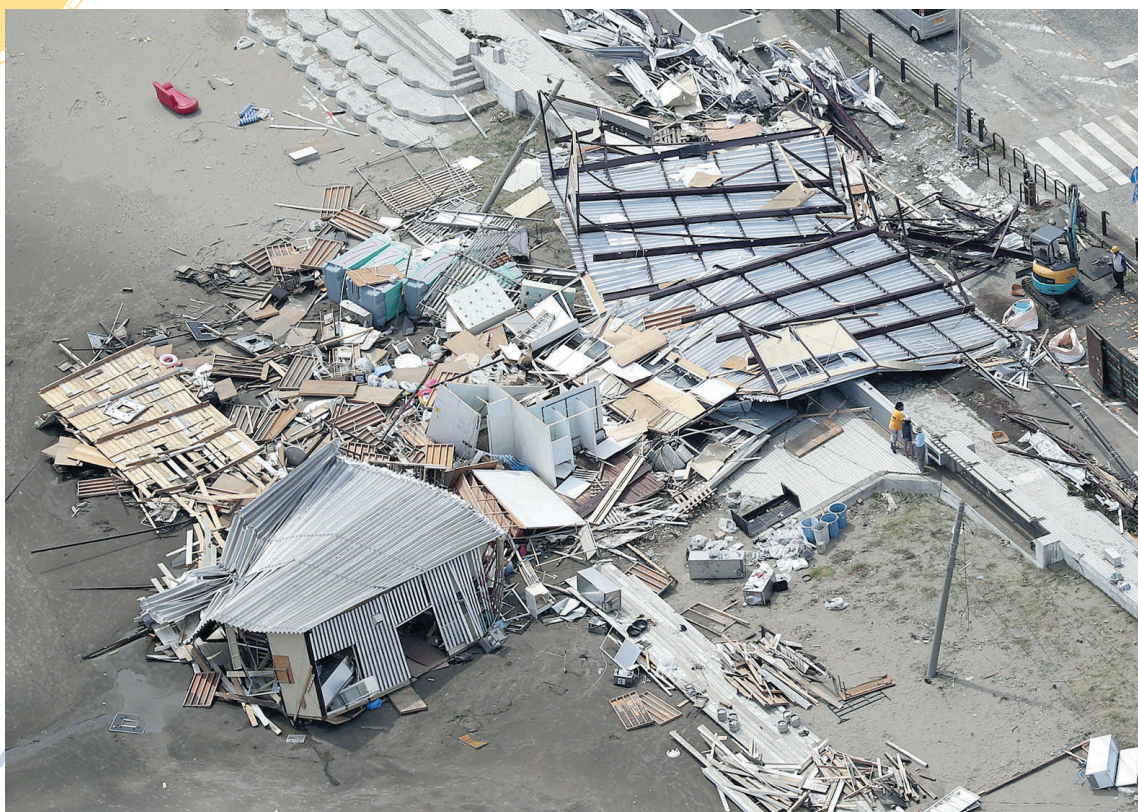
台風15号の影響で倒壊した海の家(9日午後、神奈川県三浦市 写真提供=共同通信社)
