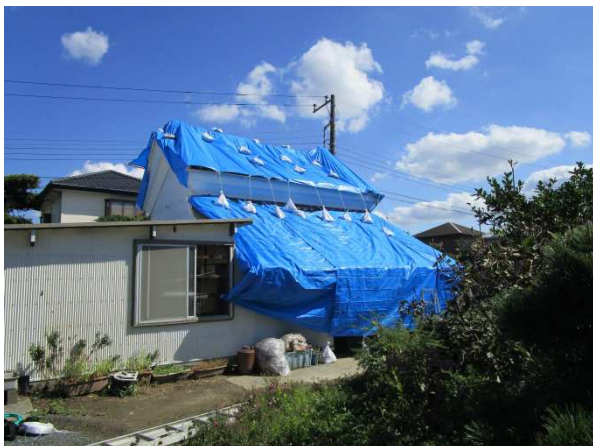
【ブルーシート設置状況】
