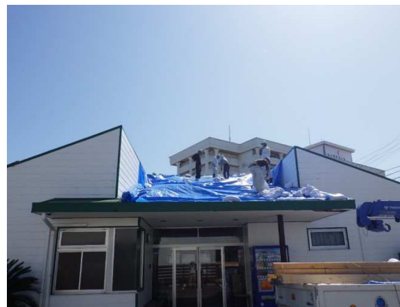
【ブルーシート設置状況】
