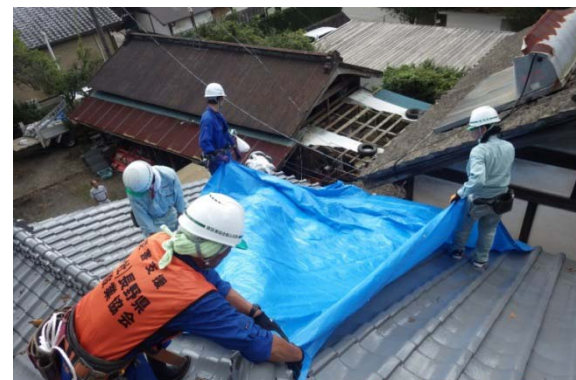
【ブルーシートの作業(芝山町)】
