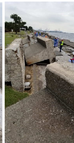
本牧D突堤 被災パラペット調査状況
