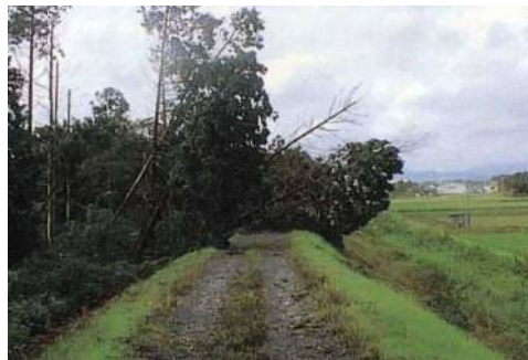
倒木により堤防へ影響
