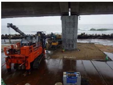
海岸に面した過酷な現場 (仮設の状況)
