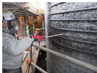
品質を確保するための防錆処理
