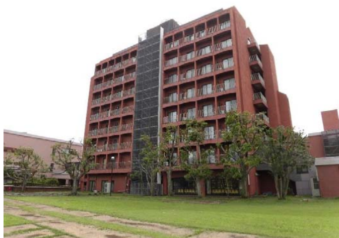
配管更新等施工状況
