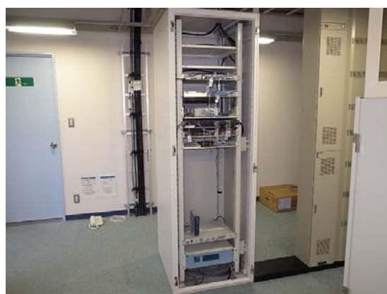
完成(高原山無線中継所)
