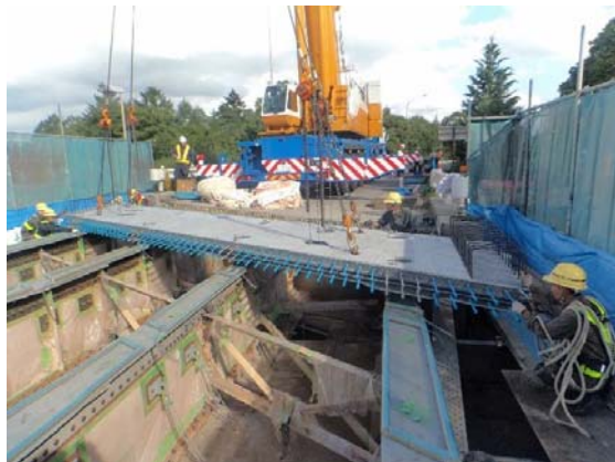
床版設置状況
