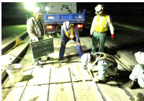
フラットバー施工状況
