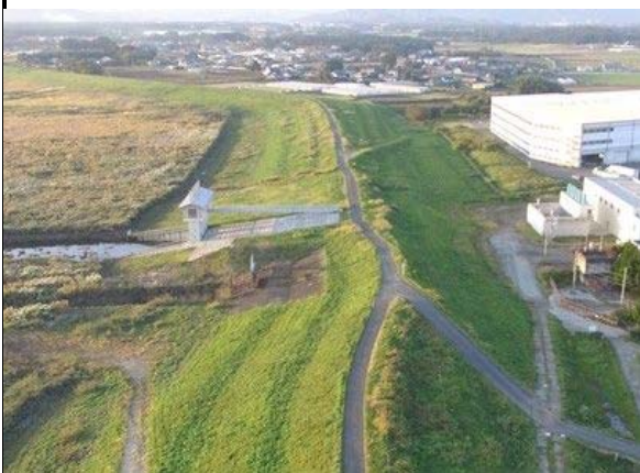
赤津樋管撤去前
