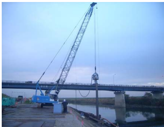
鋼矢板打設状況
