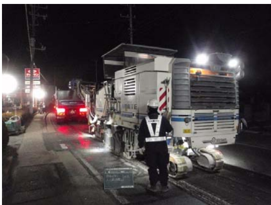
路面切削施工状況
