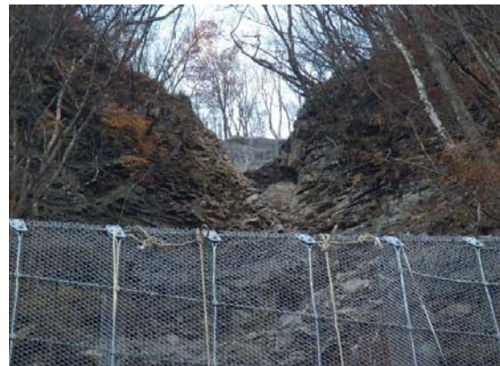
ロープネット工・落石防護網工完成
