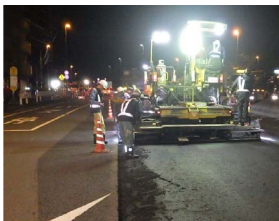
舗装敷均し施工状況
