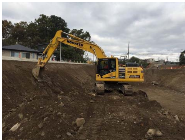
ICT土工による施工状況
