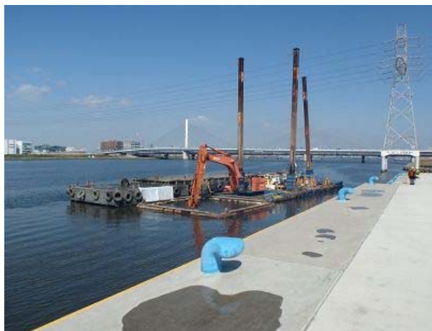
河川浚渫施工状況
