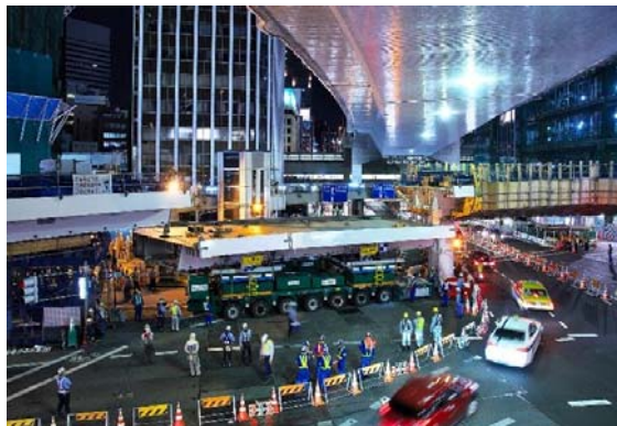
架設施工状況
