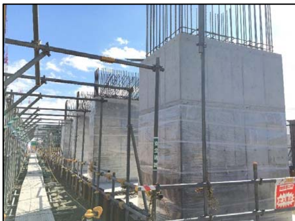
施工状況(橋脚工)
