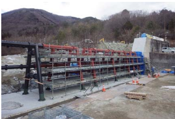
鋼製砂防堰堤施工状況
