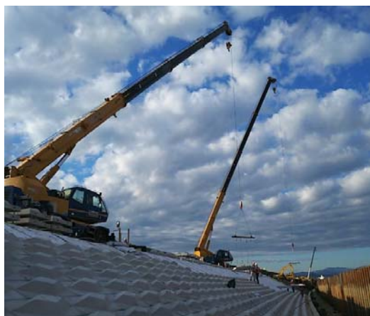
低水護岸施工状況
