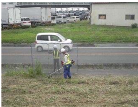
堤防除草の状況 (飛び石対策実施状況)
