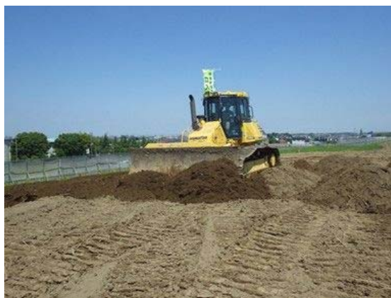
ICT施工状況(MCブルドーザ)
