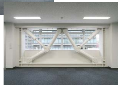
耐震補強施工状況
