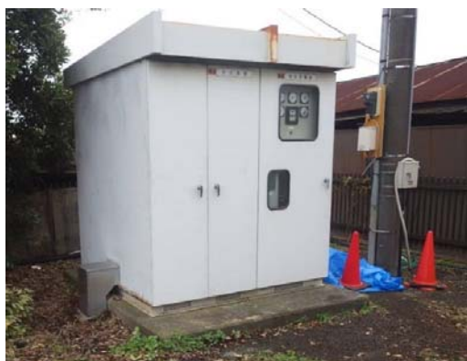
受変電設備施工前
