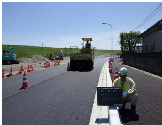
付帯道路工施工状況
