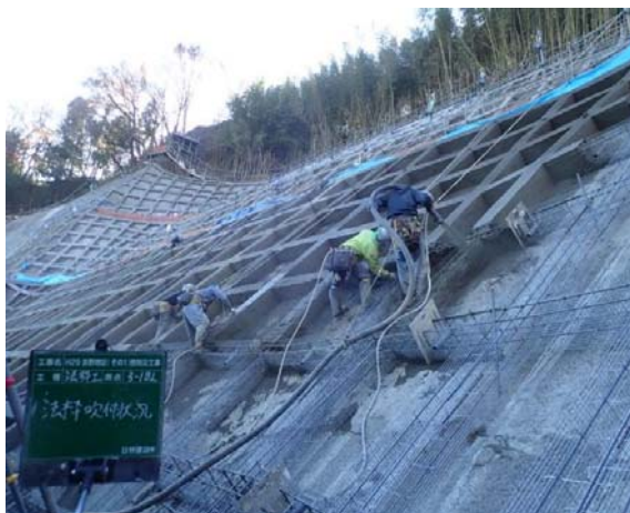
法枠吹付施工状況
