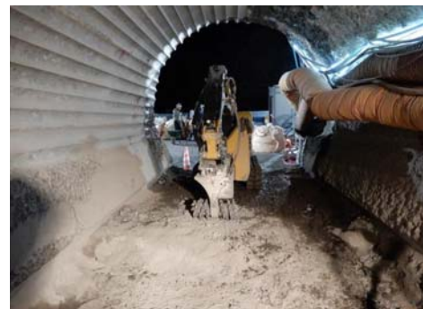
堤体削孔仕上切削状況(無人化機械)
