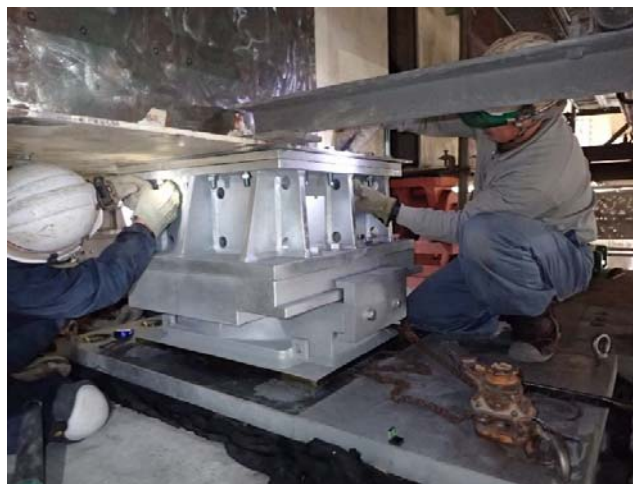
支承取替の施工状況
