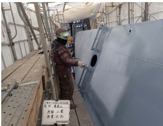
塗装工(ゲート)施工状況
