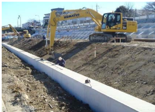
法面整形施工状況
