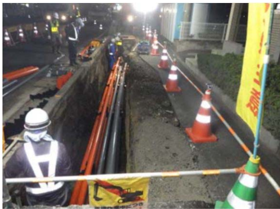
電線共同溝 管路部施工状況
