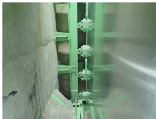
圧着シリンダー取付完成写真
