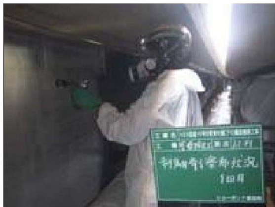
剥離剤塗布状況
