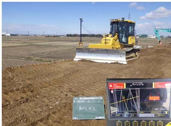
ICT土工による路体盛土の施工状況
