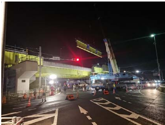
上部工桁架設 施工状況
