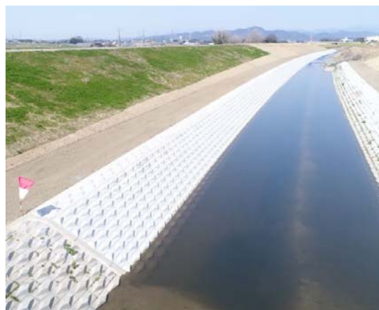
低水護岸完成
