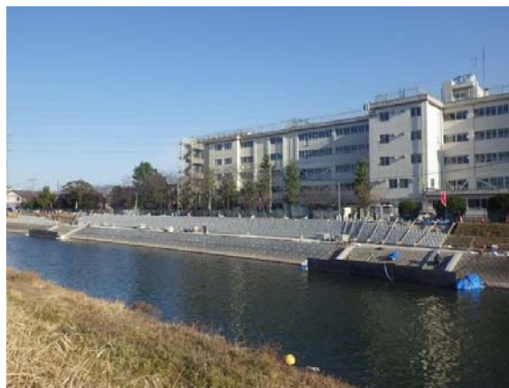
環境護岸施工状況
