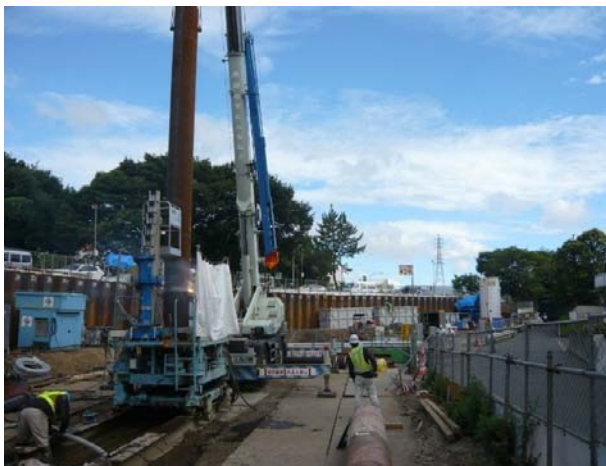
鋼管杭打設状況
