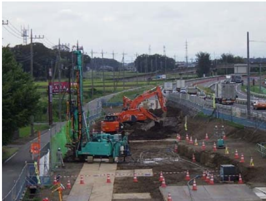
地盤改良 施工状況
