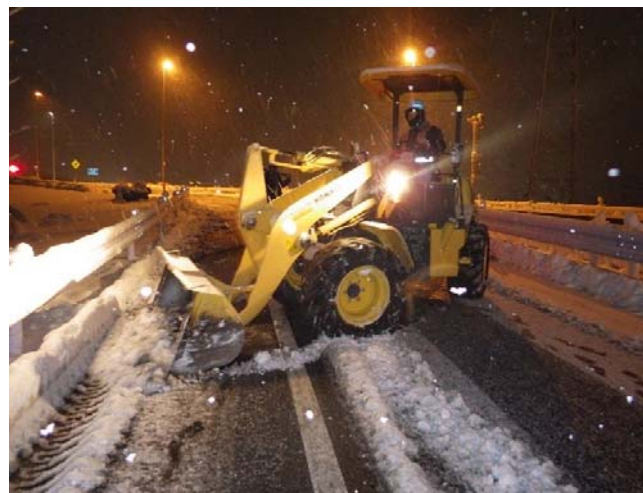
除雪作業状況
