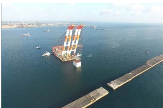
施工状況(ケーソン据付)
