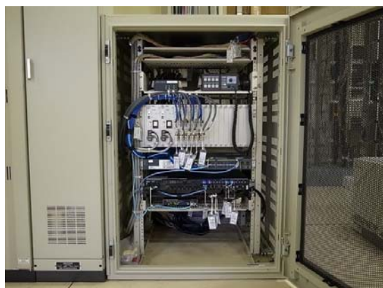
完成(五十里支所)
