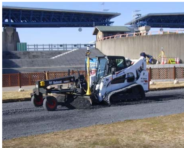
ICT舗装工(路盤工)施工状況
