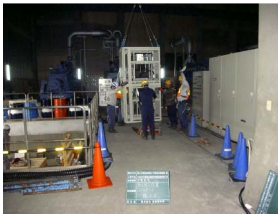
新盤搬入状況
