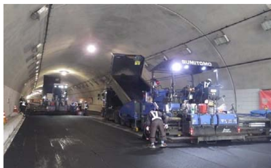
コンポジット舗装施工状況
