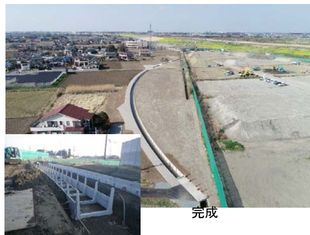
水路施工状況
