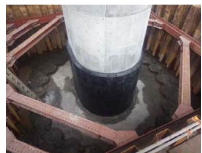
巻立補強完了時
