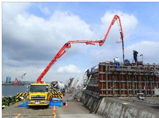
施工状況(上部コンクリート打設)
