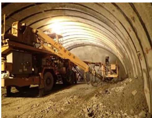
トンネル発破施工状況
