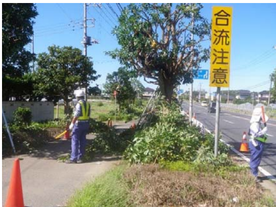
高木剪定施工状況
