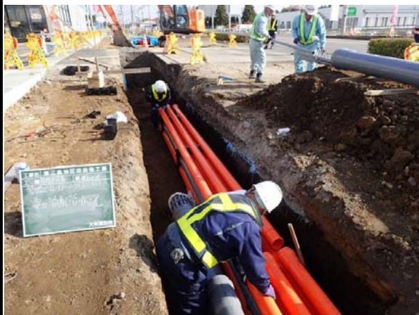
電力管配管施工状況
