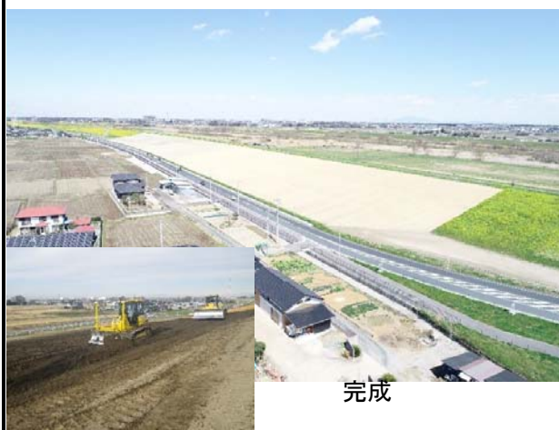
ICT施工状況
