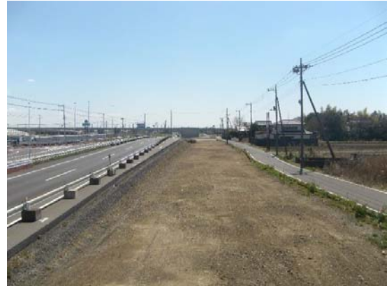
地盤改良 完成
