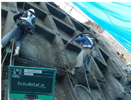
モルタル吹付状況
