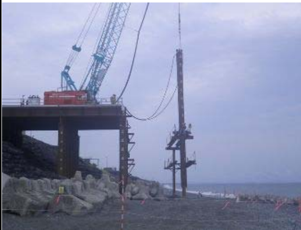
仮栈橋用鋼管杭施工状況
