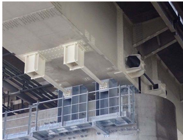
落橋防止システム装置及び支承の完成
