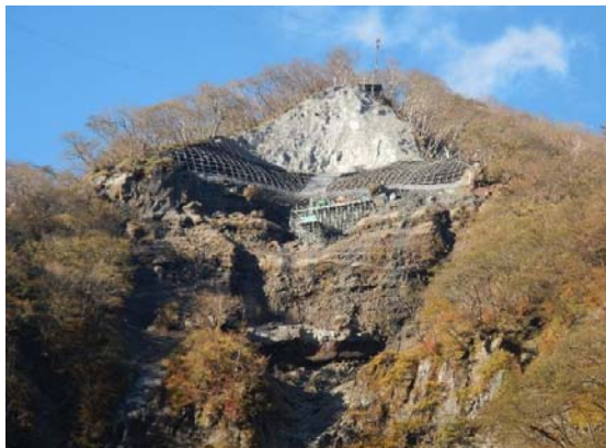
吹付砕工完成
