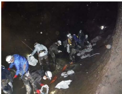
付着物撤去搬出作業状況
