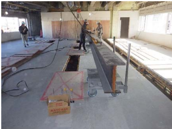
鉄骨梁補強施工状況
