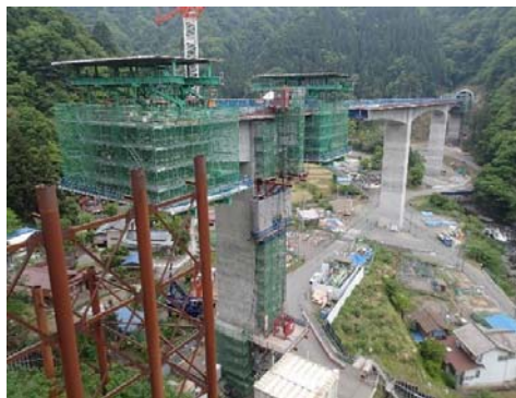
張出架設施工状況
