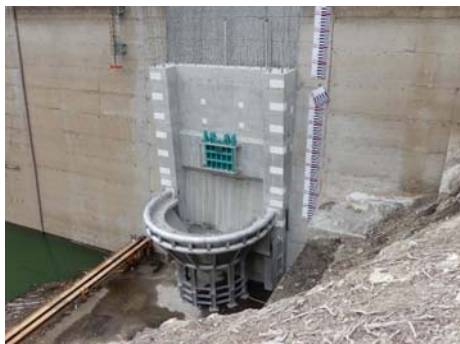
選択取水設備基礎コンクリート完成写真
