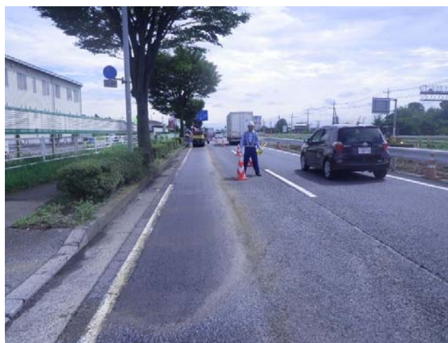
路面補修状況
