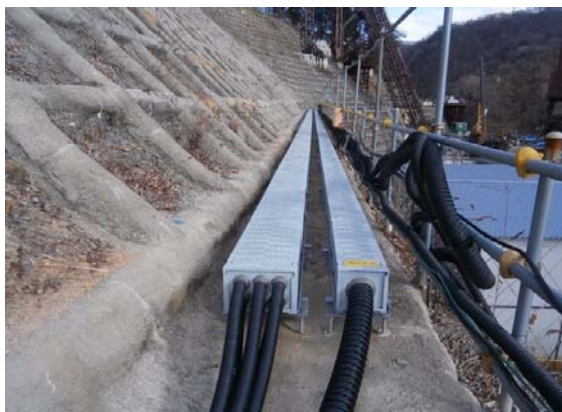
トラフ施工状況
