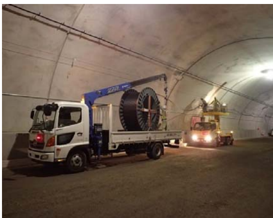
坑内ケーブル施工状況
