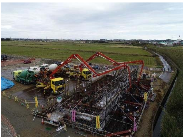
橋台底版コンクリート施工状況
