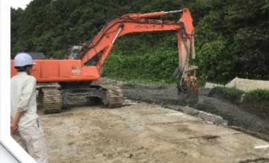
浅層混合処理工法 東関東自動車道(潮来市・築地)
