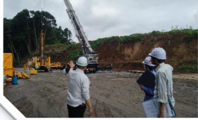
深層混合処理工法(大口径) 牛久土浦バイパス(牛久市城中)
