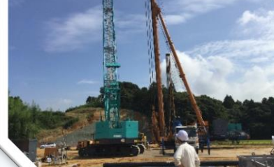
深層混合処理工法(2軸) 東関東自動車道(行方市・古高)
