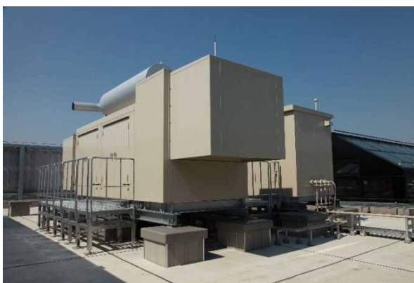
自家発電装置の屋上設置(吉川市)
