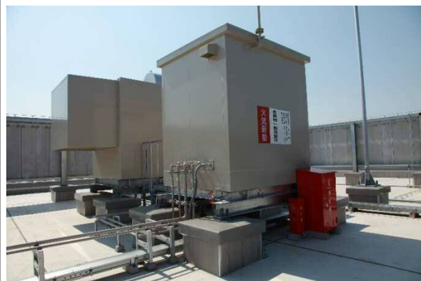
自家発電装置の屋上設置(吉川市)
