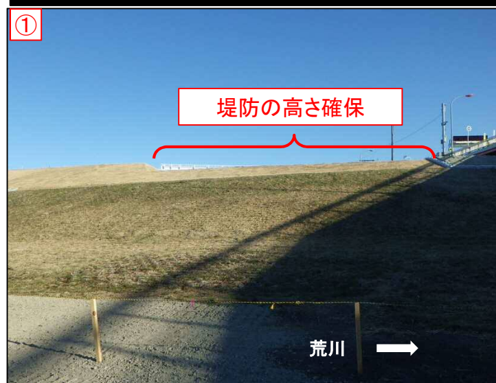
事業箇所(左岸全景)
