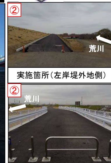
実施箇所(堤防天端舗装)
