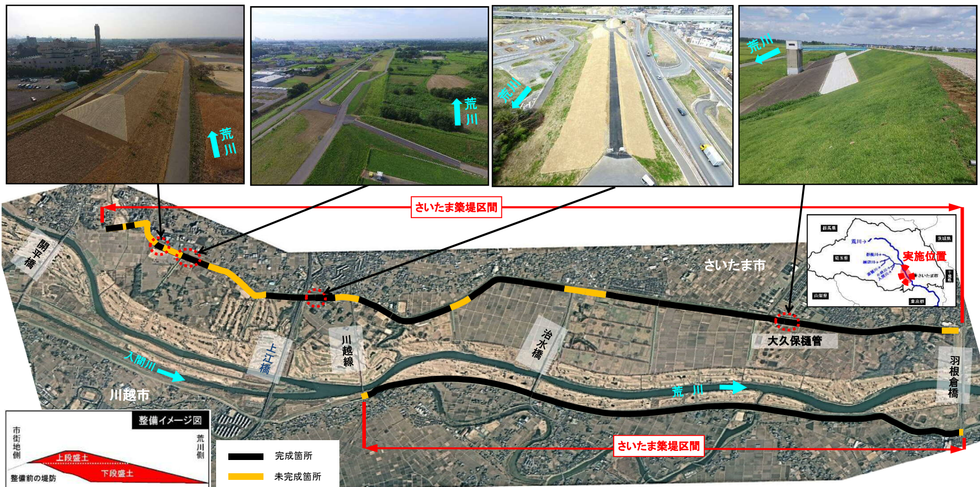
H30年度工事実施箇所
