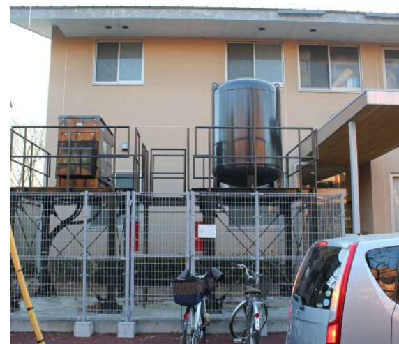
非常用電源設備のかさ上げ(宮代町)
