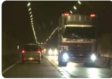
狭隘なトンネル空間
