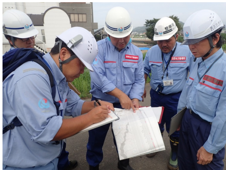
現地での作業確認
