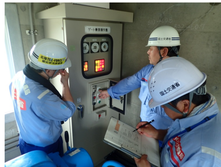
六角川水系高橋排水機場の現地調査
