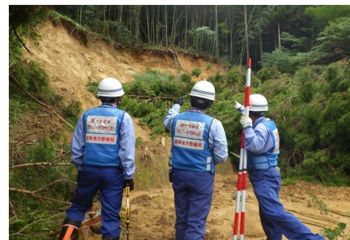
現地調査(武雄市橋町地先)
