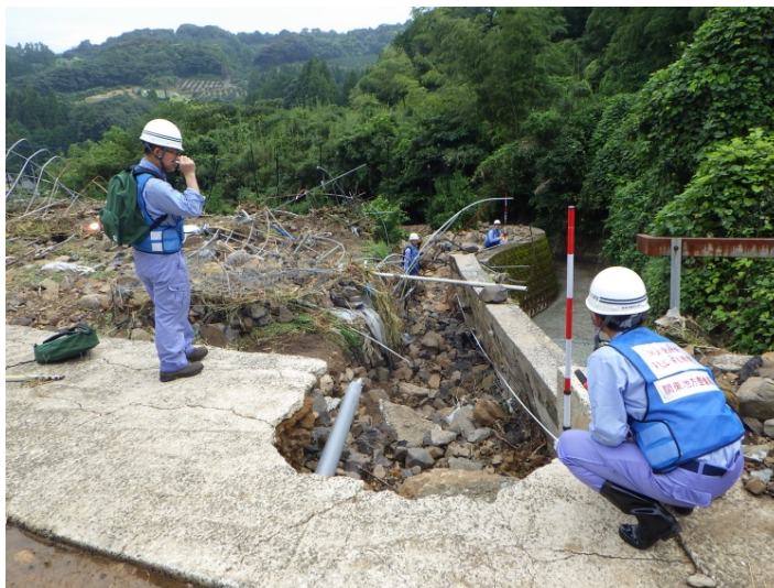
現地調査(武雄市繫昌地先)
