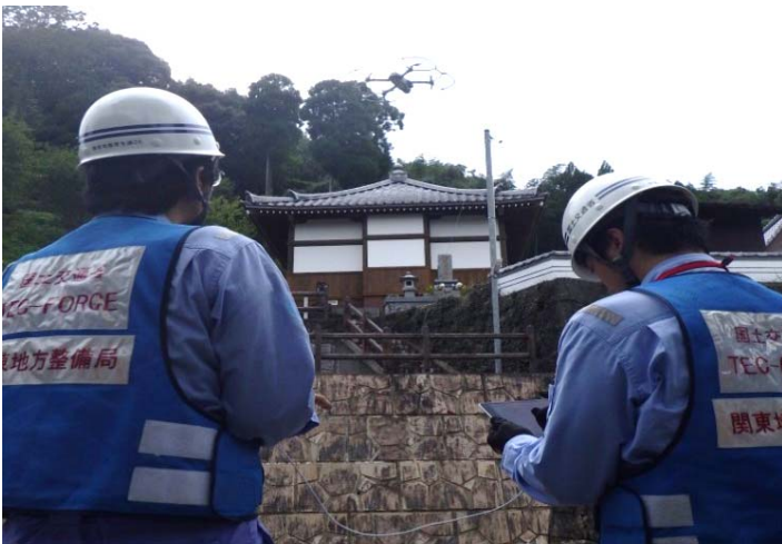
ドローンによる現地調査(武雄市橋町地先)
