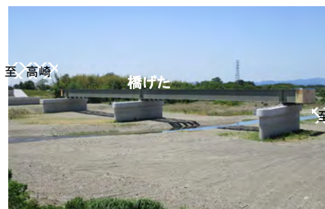
神流川橋の状況
