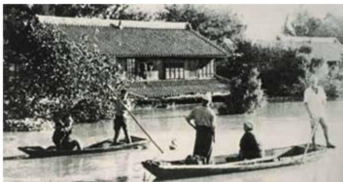
<昭和 22 年(1947 年)カスリーン台風による洪水の状況>
