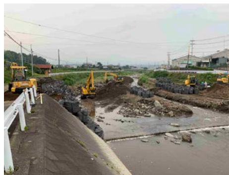
災害応急復旧作業中（6/27）
