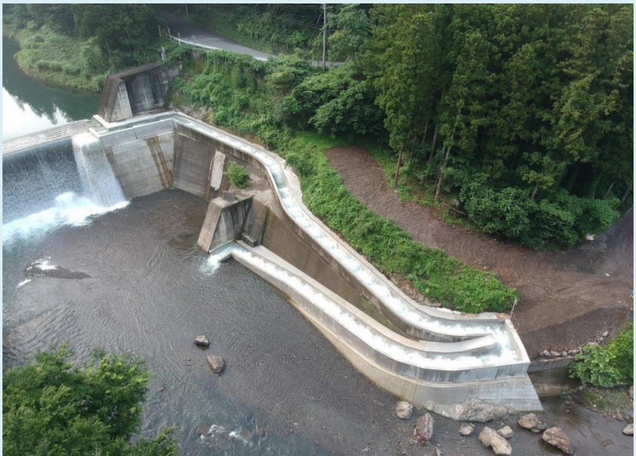
H30乙母砂防堰堤魚道改築工事
