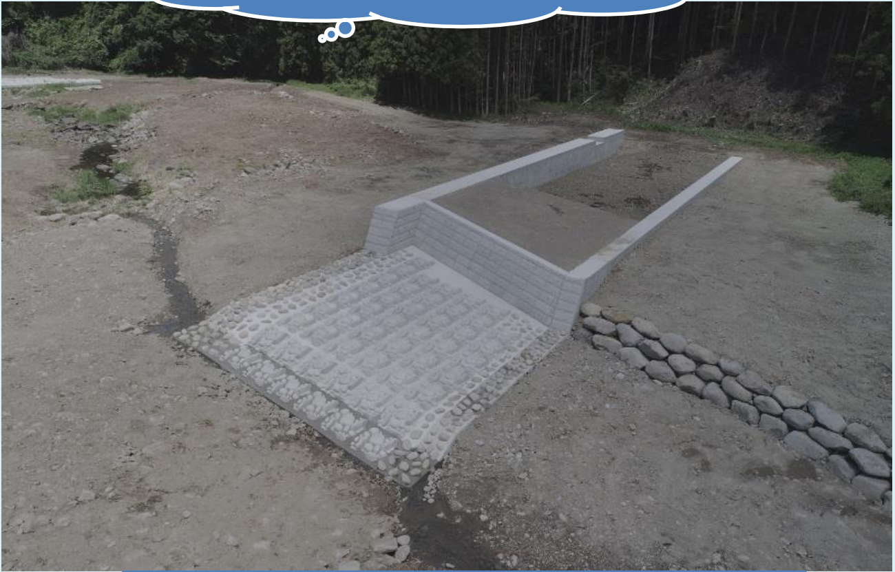
H30川浦第一床固工工事
