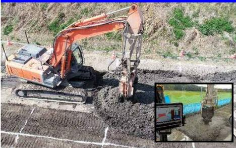
Visios-3D・地盤改良機誘導システムを使用した施工
