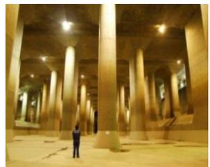
長さ177m、幅78m、高さ18m 59本の柱が立ち並ぶ調圧水槽（地下神殿）
