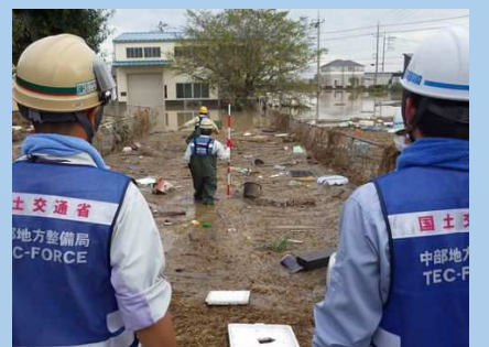
浸水区域の被災状況調査 (茨城県 鬼怒川)
