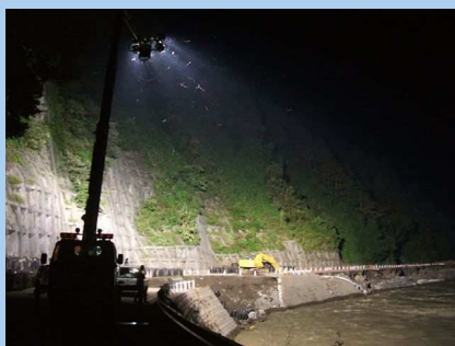
緊急通行路のための道路復旧 (岩手県岩泉町)
