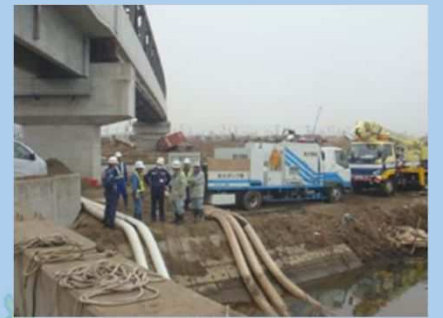
排水ポンプ車による浸水エリアの排水 (宮城県名取市)
