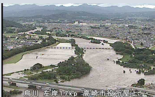
画像データ（CCTV）
