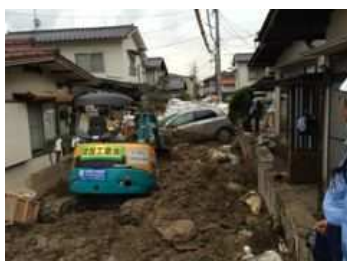
災害協定を締結している建設会社とTEC-FORCEが連携した市街地の土砂撤去（平成26年8月広島土砂災害）
