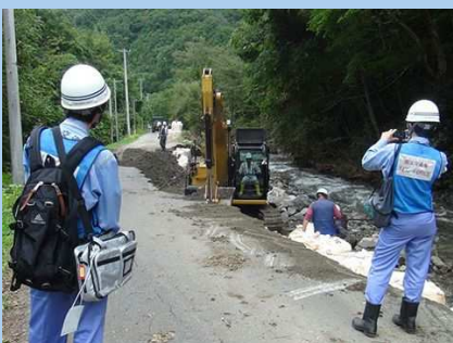
緊急通行路のための道路復旧 (岩手県岩泉町)
