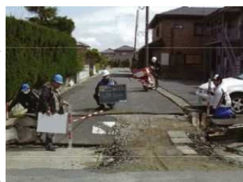
道路の被災状況の調査（平成23年東日本大震災）
