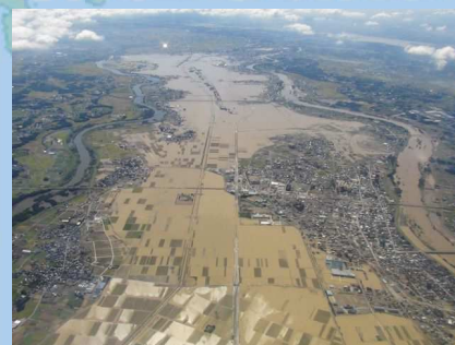
空撮による浸水状況調査 (茨城県 鬼怒川)
