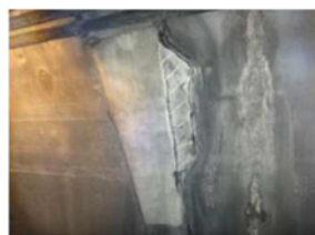
▲トンネル目地部
