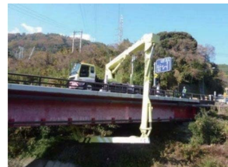
橋梁点検車による点検状況
