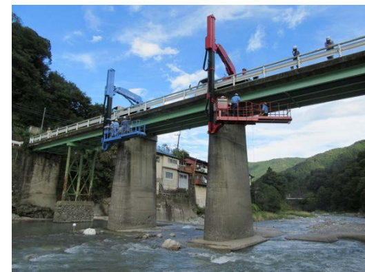
御鉾橋（群馬県）における直轄診断(H28)
