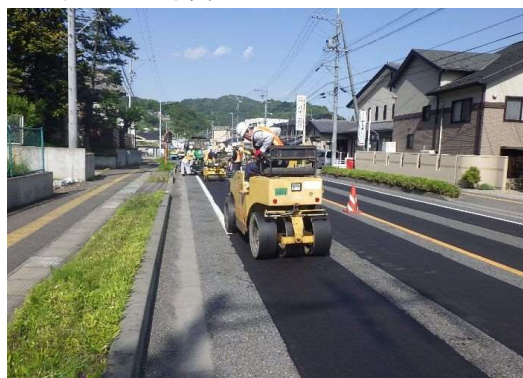
施工状況(レール舗装)
