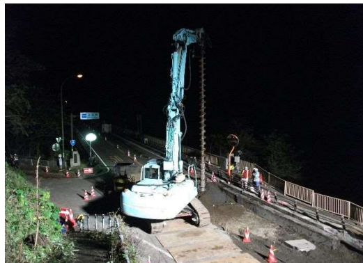
長野市信州新町水内地区応急対策
