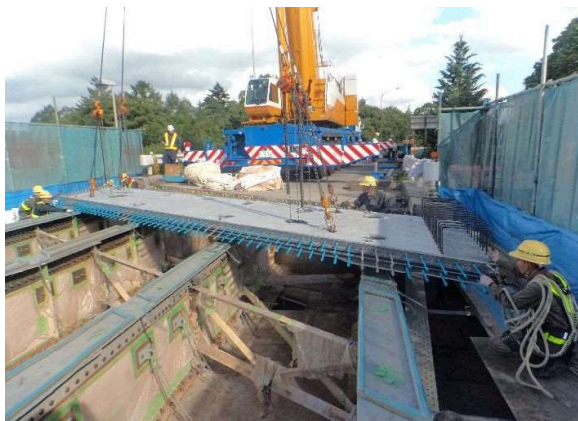
床版設置状況
