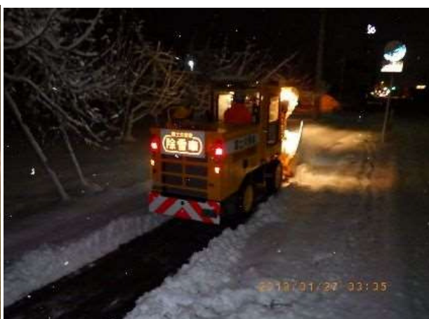
歩道除雪 作業状況
