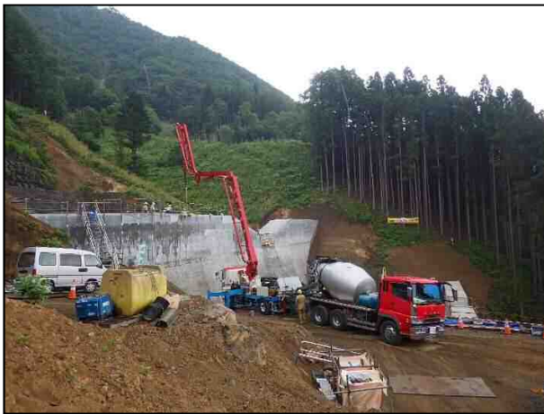
砂防堰堤施工状況
