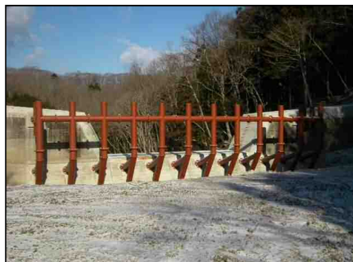
流木補足工 完成
