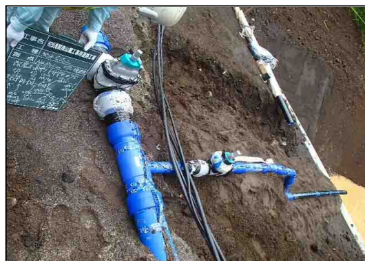
水道管移設施工状況
