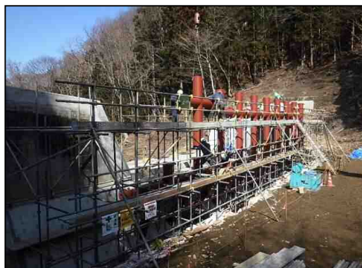
流木補足工施工状況
