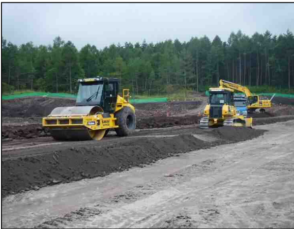
ICT 施工状況
