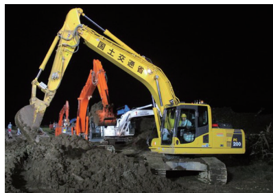
河道掘削作業
