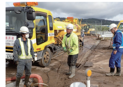
路面清掃作業
