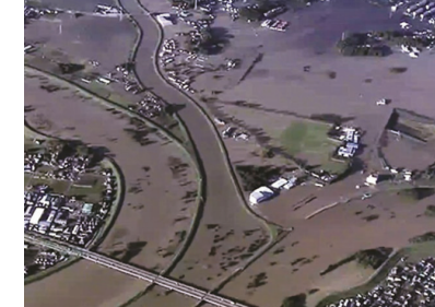
被災状況調査 （災害対策用ヘリより撮影）
