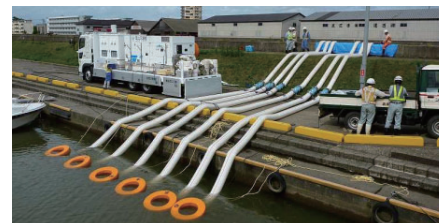
排水ポンプ車による排水状況
