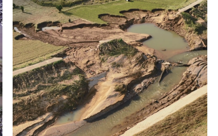
被災状況調査 （ドローンより撮影）
