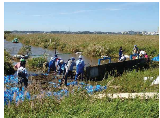
平成 30 年 10 月 除去作業状況
