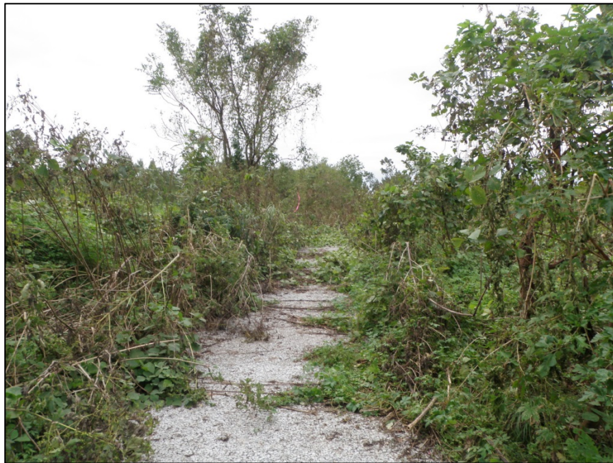
中池管理用通路上に伸びるクズ (2018年10月13日撮影)
