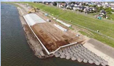
ドローンによる日々の進捗管理
