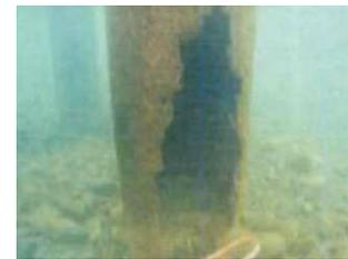
▲橋脚水中部の断面欠損
